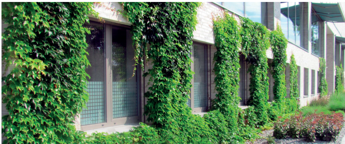
Zelená fasáda budovy Centra přírodovědných a technických oborů, sídla Fakulty životního prostředí a Přírodovědecké fakulty Univerzity Jana Evangelisty Purkyně. Foto: Břetislav Koč
